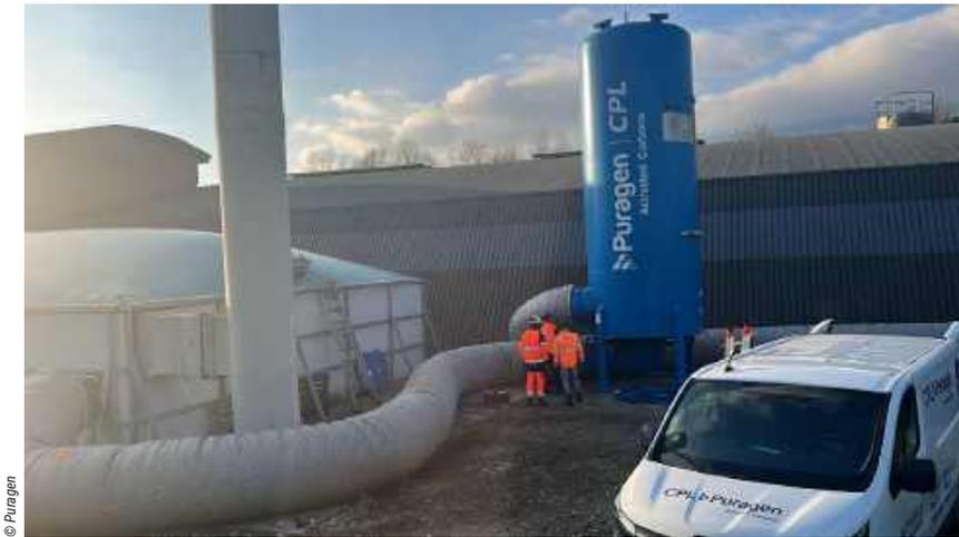
L'équipe de service de Puragen a réalisé une connexion sur mesure afin de réduire les dépenses d'investissement et de faciliter la mise en place.
