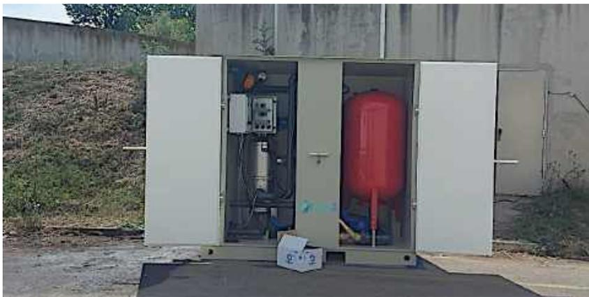
Un skid REUT de 1h2o3 en LOA regroupe une pompe, un filtre automatique, un débitmètre, des traitements UV et de chloration, pour un débit de 45 m<sup>3</sup>/h.
