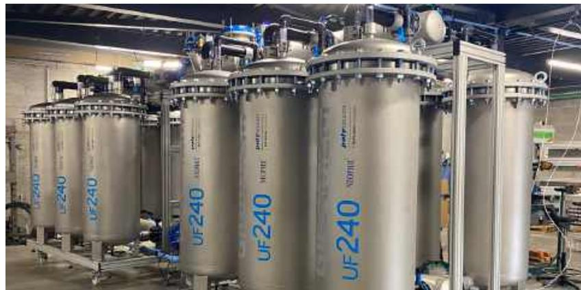
L'ultrafiltration développée par de Polymem et reposant sur la technologie Neophil en modules Gigamem permet de produire, en une étape purement physique et basse pression, une eau de qualité A et A+.
