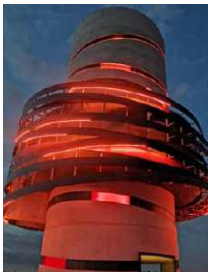
Figure 3a. Réservoir de Bully-les-Mines / CALL (62).
