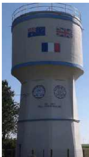
Figure 2d. Réservoir de Bullecourt / Noreade (62).
