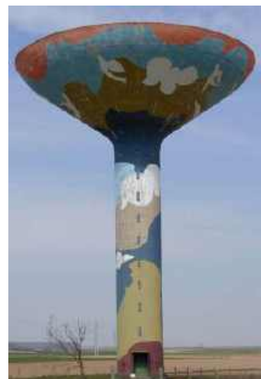
Figure 2a. Réservoir de Mareuil / CUA (62).
