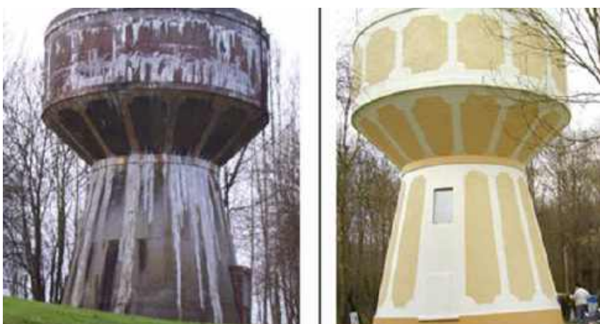
Figure 5a. Rénovation avant-après du réservoir de Beaumetz-les-Loges / CUA (62).
