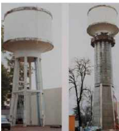
Figure 5b. Surélévation du réservoir CEA de Monts (37).
