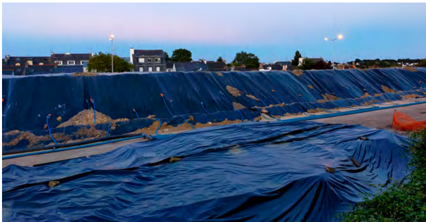
Colas Environnement réalise, ici, la reconversion d'une friche par biotraitement de terres impactées aux hydrocarbures.
