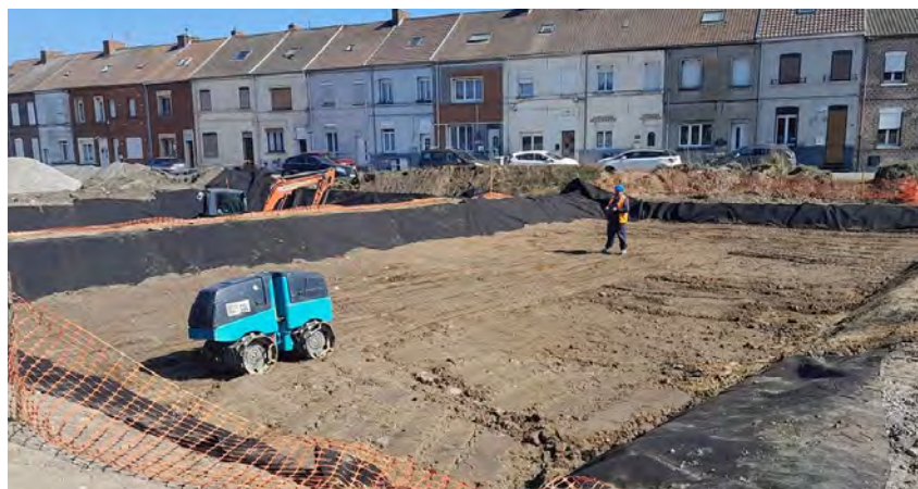
MP Geotex a mis en place son géotextile MP Cocoon sur un chantier à Anzin, en périphérie de Valenciennes (Nord).
