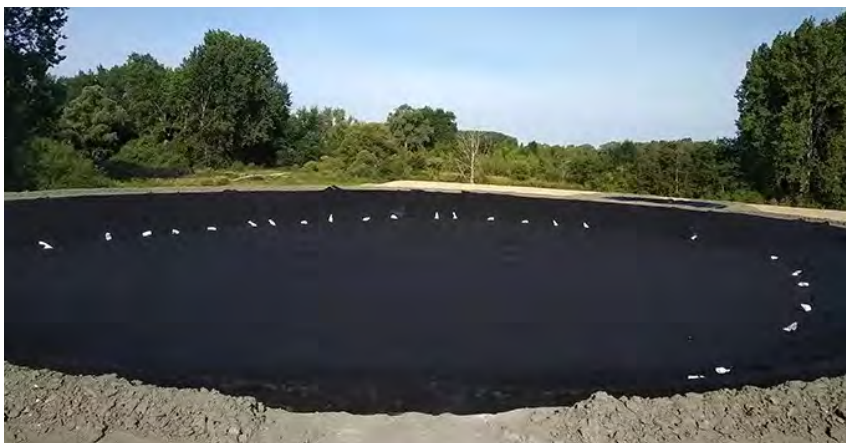
Il s'agit, ici, du confinement de terres polluées sur le site d'une ancienne blanchisserie, d'une surface de 11500 m 2 , dans une commune des Hauts-de-France.
