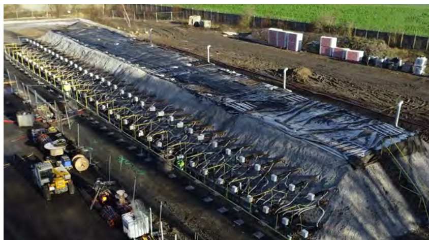
Sur ce site de Harnes (Pas-de-Calais), le traitement des terres par désorption thermique est assurée par Haemers Technologies, Sêché Environnement réalisant l'ensemble des prestations, à l'exception de celle de la désorption thermique.
