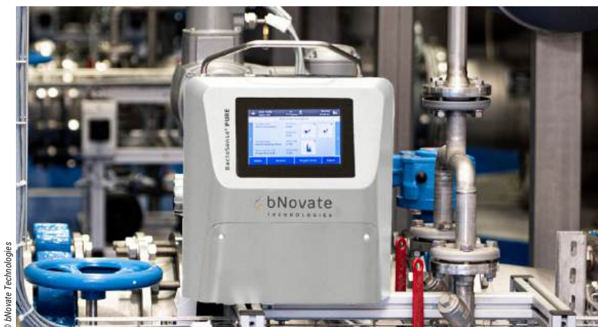
Le système BactoSense Pure de bNovate Technologies est dédié à la surveillance microbiologique de la qualité de l'eau.
