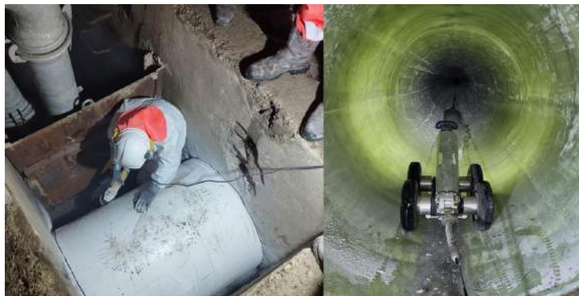
Chantiers de réhabilitation sans tranchée chez Orea Group : du curage à la pose de gaines, les interventions réalisées depuis les regards pour rénover les canalisations ont un impact limité en surface.
