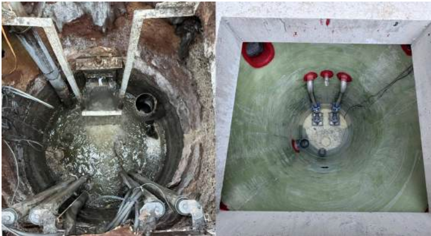
Ce chantier, réalisé en mars 2026 par Sogea Environnement (groupe Vinci Construction) avec son fournisseur de gaines Brandenburger, porte sur un poste de relèvement (avant et après) de DN1500 et d'une profondeur de 3,50 m.
