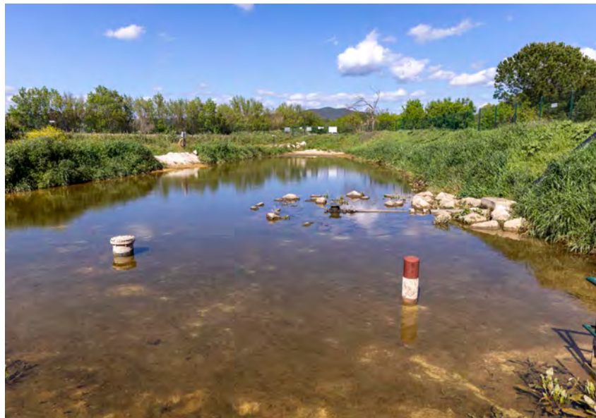
Avec le changement climatique, l'enjeu n'est plus seulement de gérer les conséquences d'une crise, mais d'anticiper les vulnérabilités plusieurs années à l'avance (ici, des bassins de réalimentation Aquarenova à Hyères).
