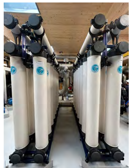
Le programme Jourdain en Vendée utilise l'unité d'affinage des Sables-d'Olonne pour recycler des eaux usées traitées en eau potable, en combinant des modules UF, l'osmose inverse basse pression Barrel de Veolia et une désinfection UV.
