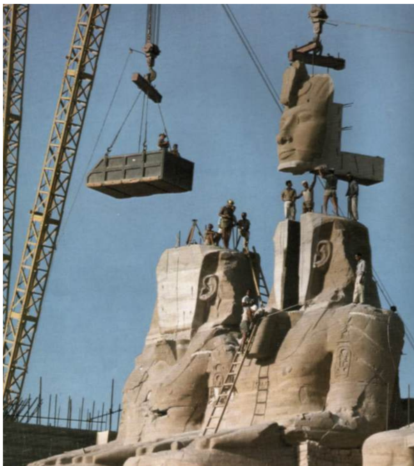
Déplacement des temples d'Abou Simbel dans les années 1960 : les statues géantes de Ramsès II découpées en blocs pour être remontées hors d'atteinte du lac.
