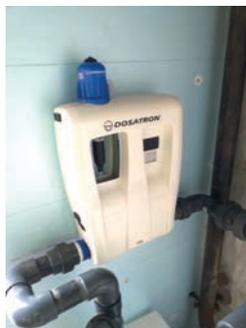
Basée sur la technologie Dosatron, qui conçoit depuis 40 ans, des systèmes de dosage sans électricité utilisés dans de nombreux domaines, dont ceux de la potabilisation et de la désinfection, la nouvelle ligne de pompes doseuses D30 Water Line offre une solution pour le dosage haut débit sans raccordement électrique. Elle est conçue spécialement pour doser les additifs alcalins ou acides dans l'eau.
