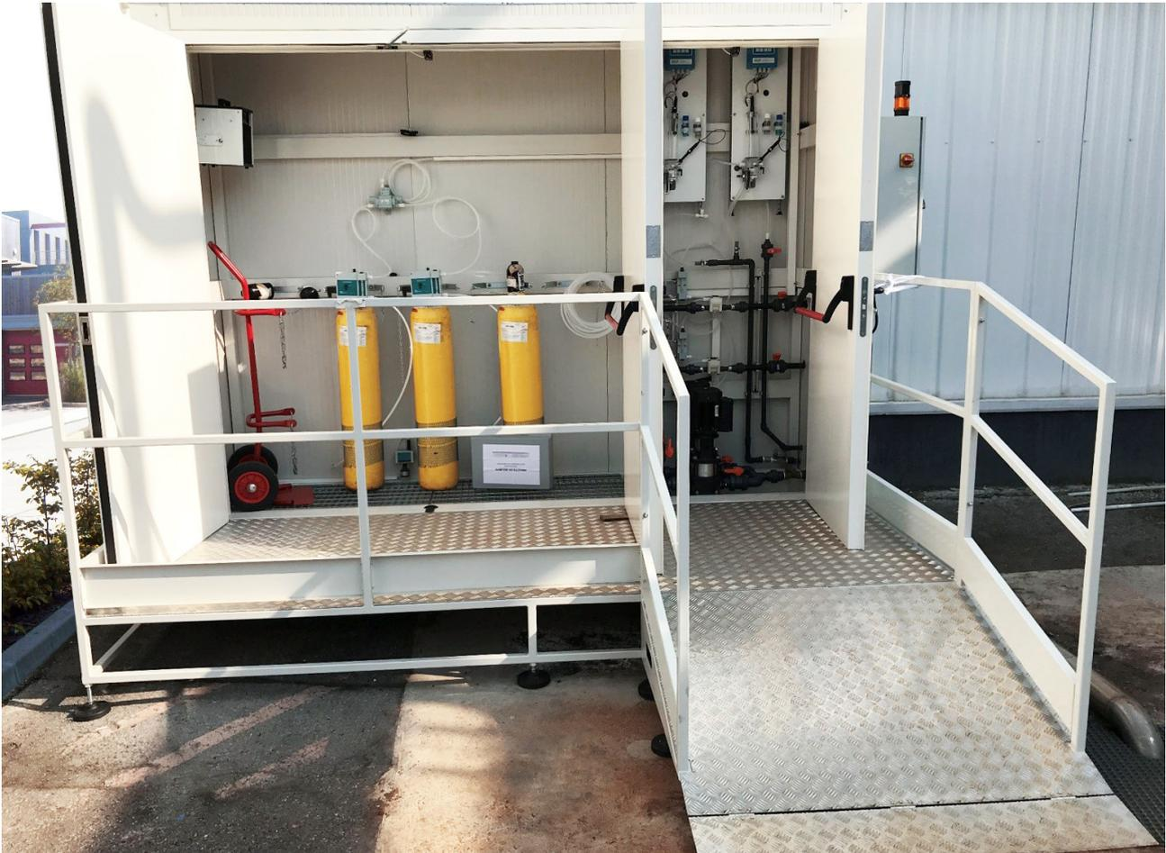
Armoire de chloration avec les parties stockage et utilisation séparées
