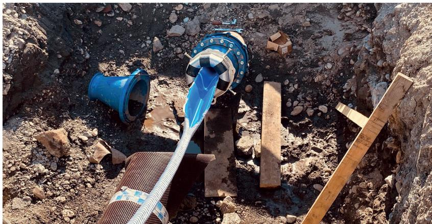
directement un retubage de la canalisation existante fuyarde, alors qu'au départ il était question de poser une sauterelle pour rétablir dans l'urgence le réseau, en attendant de réparer la conduite existante. Là, le Syndicat a même pu choisir et adapter le diamètre, et préféré le DN200 qui suffisait plutôt qu'un DN300.
