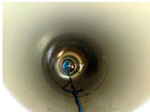
**5 mois et demi de travaux en microtunnel ont permis de poser, en un seul tir rectiligne, 299 tuyaux de 3 ml en PRV.**
