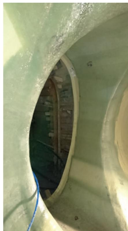
**Assurés par les équipes techniques de Hobas, les travaux de laminage ont consisté à coller puis assembler les pièces à l'aide de 18 bandes de fibres verre d'une épaisseur totale de 18 mm imbibées de résine catalysée.**
