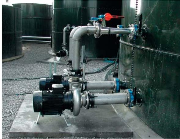
Pompe AirJet installation sèche pour un bassin d'aération dans une confiserie.
