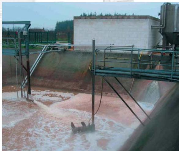
Système combiné d'une pompe immergée AirJet et d'un agitateur submersible dans un bassin tampon de conserverie.
